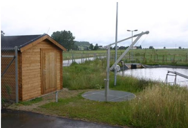
Dezentral und naturnah: die Kläranlage Faha gehört zur Gemeinde Mettlach
