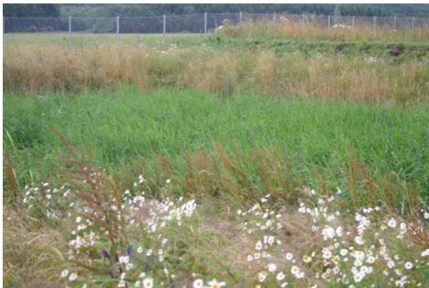
In den Pflanzenbeeten reinigen Millionen von Mikroorganismen das Abwasser.
