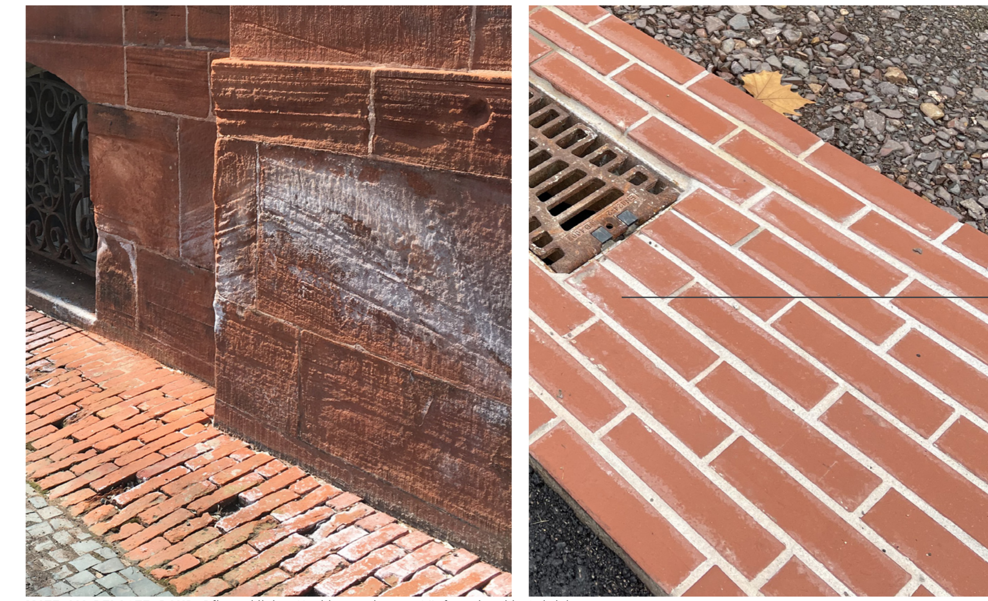
MATERIAL PFLASTERBAND: Pflasterklinker, Hochkantverlegung, Läuferverband in Gehrichtung
