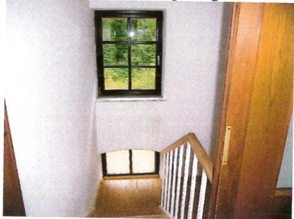
Holzfenster mit Isolierverglasung
