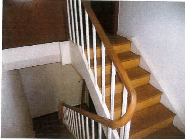
Holztreppe zum OG
