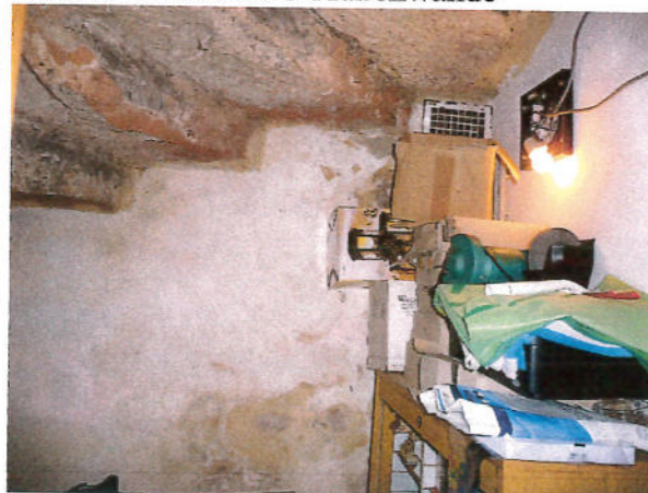
Feuchteschäden KG-Außenwände
