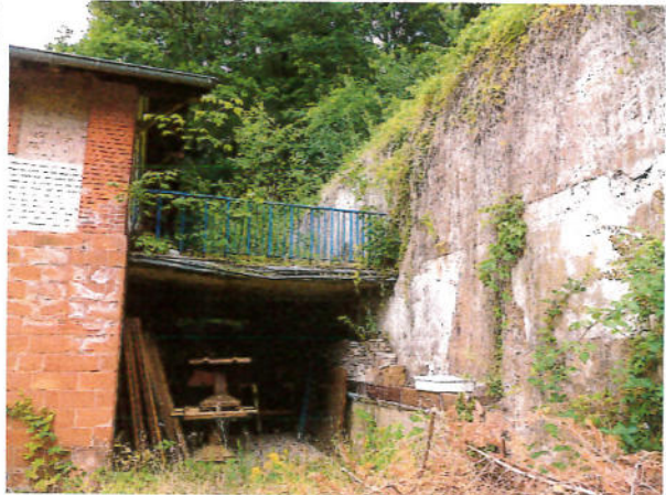
statisch zu überprüfende Stützmauer
