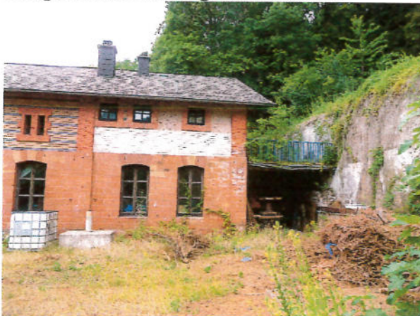
Beispiel Ausbesserungsstelle Fassade
