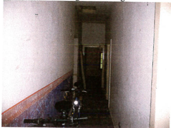
OG-Flur in ehemaliger Wohnung
