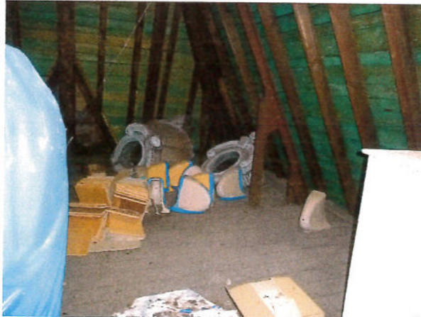
Speicherboden im Westturm
