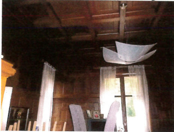
Decken und Wände mit Holzverkleidung
