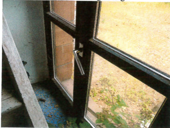
Holzfenster mit Isolierverglasung
