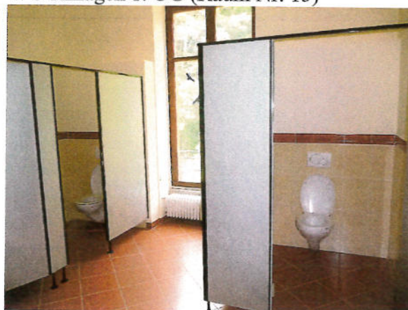
WC-Anlagen 1. OG (Raum Nr. 15)
