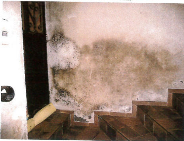
Schimmelbefall KG-Mauerwerk
