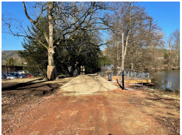
Foto: Bauarbeiten im BA 5 (entlang des Langweihers)
